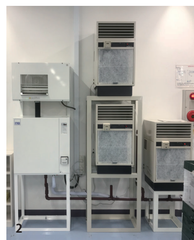
1：除加湿器使用の製造室 2：左は蒸気式加湿器SU、右は除湿機DH。湿度環境によって加湿運転もしくは除湿運転を選択する使い方。運転/停止/希望湿度を設定するのみ。
